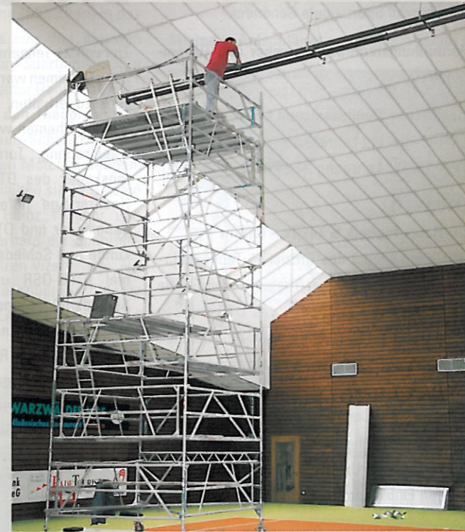
Generalstabsmäßig geplante Montage mit Hilfe zweier Gerüsttürme.
